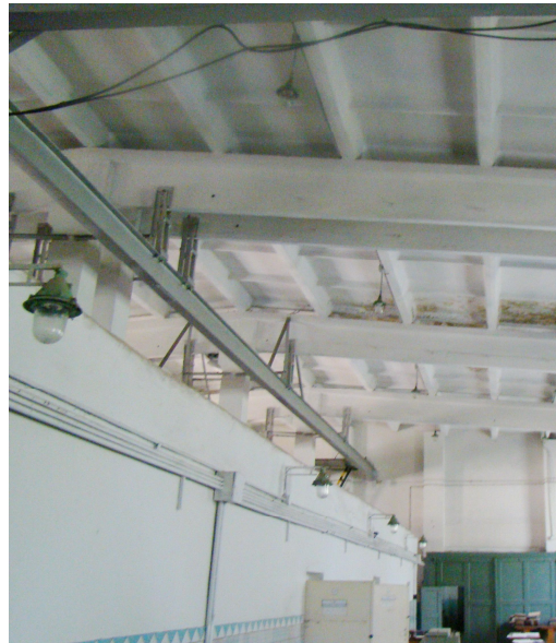
Рис. Каркасні споруди, в яких досліджувались спектри власних частот і форм, а також розподілення внутрішніх зусиль та напружень
