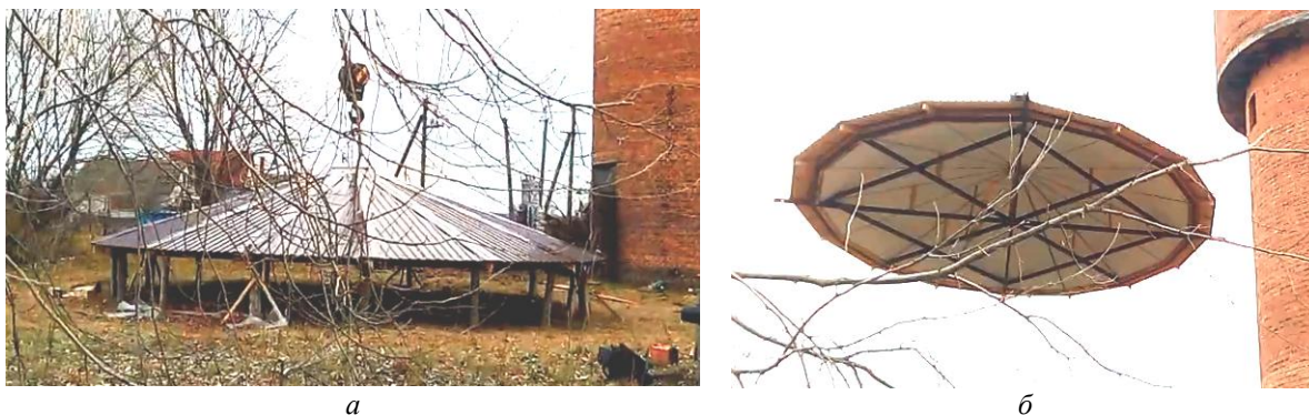
Рис. 1. Монтаж покрівлі: а – тимчасове кріплення і стропування; б – під час монтажу
