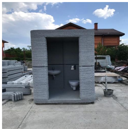
Рис. 3. Будівельна продукція створена за технологією 3D-друку
