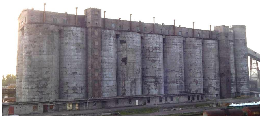
Рис. 1. Споруда, технічний стан якої досліджувався: 1. Силоси. 2. Надсилосна галерея. 3. Зовнішні сходові клітини
