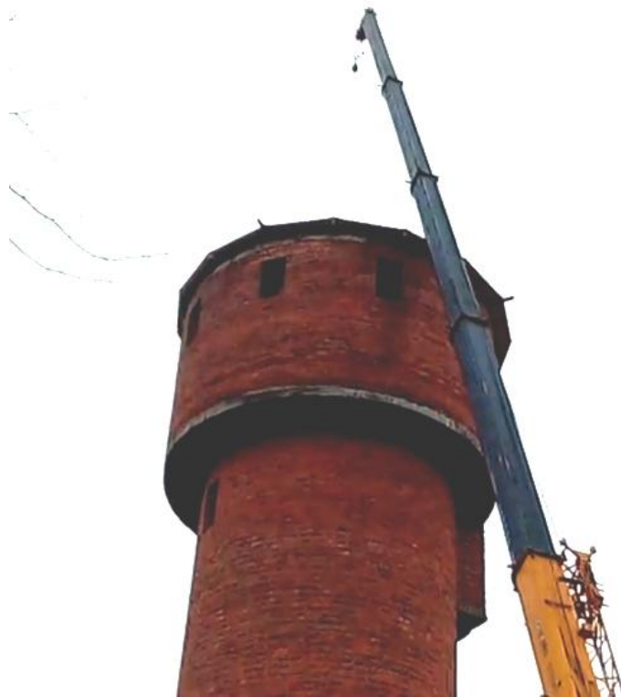
Рис. 2. Встановлення покрівлі в проектне положення
